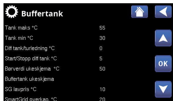
Meny «Avansert/Innstillinger/Buffer tank»
